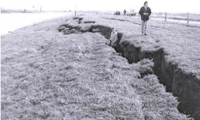
Foto 1 Scheuren in de Maasdijk bij Asselt als gevolg van de beving bij Roermond op 13 april 1992 (Rijkswaterstaat)
